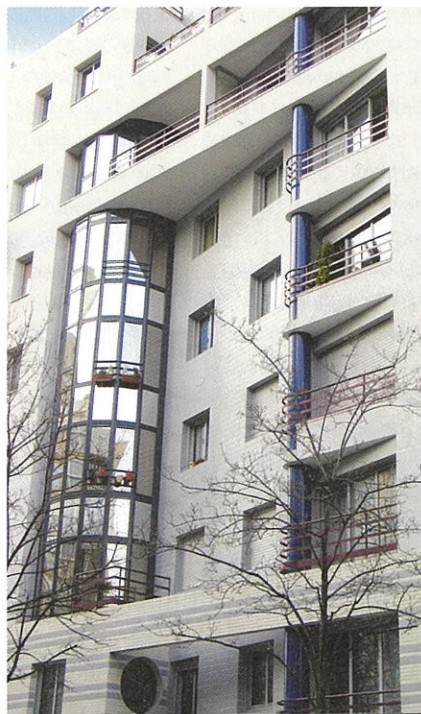
Jean-Pierre Buffi, immeuble, 18-20, rue Mathis, 19 e , 1982 : détail de la partie creusée de la façade. (Jean-Pierre Buffi, © Adagp, Paris, 2007)
